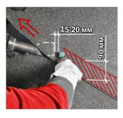
Выполните сварной шов шириной не менее 90 мм — ролик должен двигаться параллельно соплу фена на расстоянии 15-20 мм от него.
