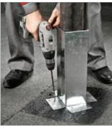
Закрепите стакан в основание при помощи саморезов.
