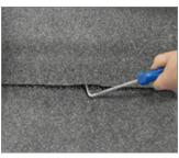
В месте, где отсутствует вытек вяжущего, контроль шва выполняют при помощи шлицевой отвертки.
