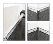
Зазор между стеной и отгибом краевой рейки заполните полиуретановым герметиком (герметик полиуретановый ТЕХНОНИКОЛЬ №70).
