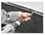
Приклеенный на вертикальную поверхность материал закрепите механически при помощи краевой рейки.
