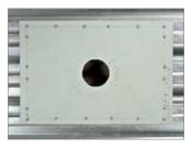
Места прохода сквозь стальной профилированный настил коммуникаций (трубы, водоприемные воронки и прочее) и опор инженерного оборудования усильте оцинкованной сталью толщиной не менее 0,8 мм.
