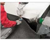
Внутренний угол усильте полосой из материала Техноэласт ЭПП шириной 200 мм.
