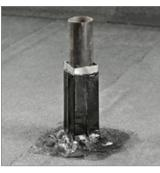
Обклейте стакан материалом Техноэласт ЭПП при помощи горелки или фена.
