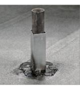
Выполните усиление кровли в переходе с горизонтали на вертикаль из материала Техноэласт ЭПП.
