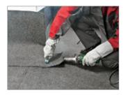
Закончите обрамление углов при помощи фена горячего воздуха и силиконового ролика шириной 28 мм.
