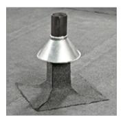
Установите юбку из оцинкованной стали на трубу. Плотно затяните обжимной хомут.
