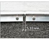
Между смежными элементами крепления оставляйте температурный зазор 5-10 мм.
