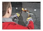
Для качественного наплавления по крупнозернистой посыпке произведите ее удаление из зоны сварки.
