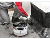
Нанесите мастику для гибкой черепицы ТЕХНОНИКОЛЬ № 23 на место приклейки при помощи зубчатого шпателя.
