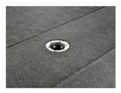
Произведите автоматическую сварку полотнищ в продольном шве, при необходимости подваривая края ручным феном.
