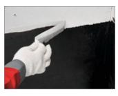
Снимите малярный скотч с огрунтованной стены. Огрунтованный край получился ровным.
