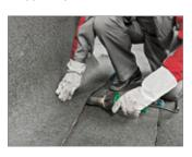
Прихватите заготовку феном у переходного бортика, чтобы избежать смещения и образования складок при работе автоматом.
