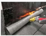
В качестве альтернативного варианта укладки возможно использовать наплавление на вертикальную поверхность.
