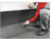
Для качественной приклейки прикатайте Техноэласт СОЛО прикаточным роликом шириной 80 мм.
